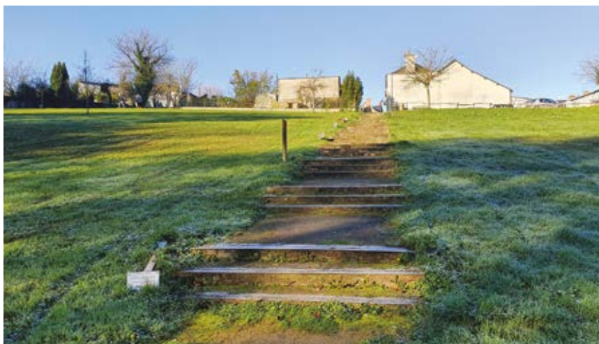
Dégradations de l'« Allée du Jumelage », à l'espace du Luget
