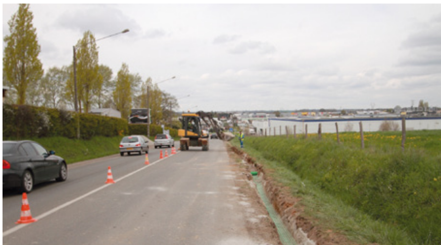
L'enfouissement de la fibre
