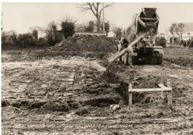
Les premiers travaux de la salle des fêtes en 1975
